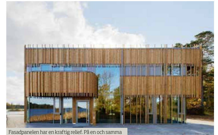
Fasadpanelen har en kraftig relief. På en och samma fasad exponeras panelerna mot tre väderstreck, fasaden upplevs olika beroende på var betraktaren står.
